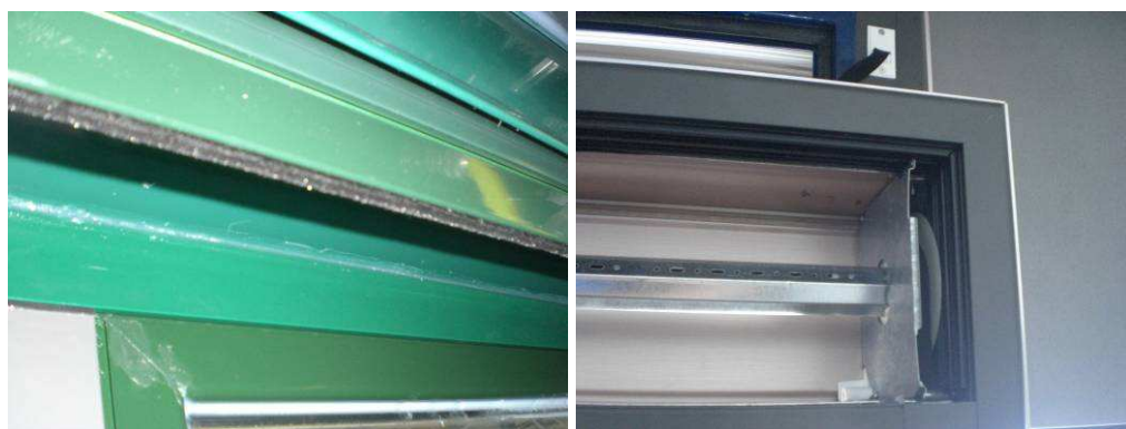
Foto N°.4. Detalle de salidas de cinta de persiana.
