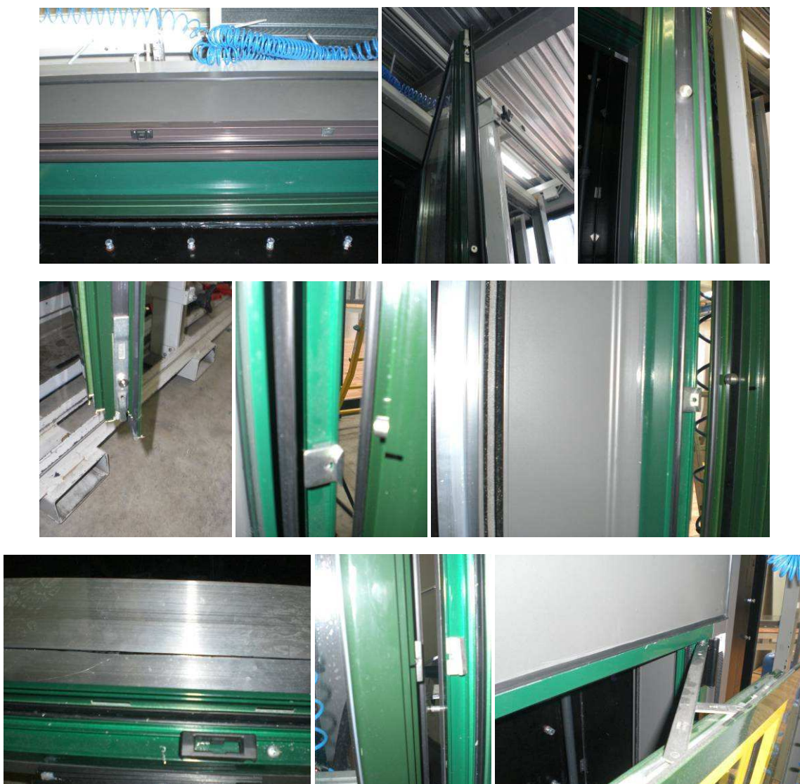
Foto N°6. Detalle de perfiles, juntas y puntos de cierre.
