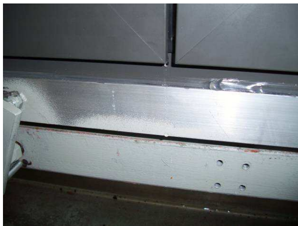
Foto N°.6. Detalle de la zona de goteo de agua.
