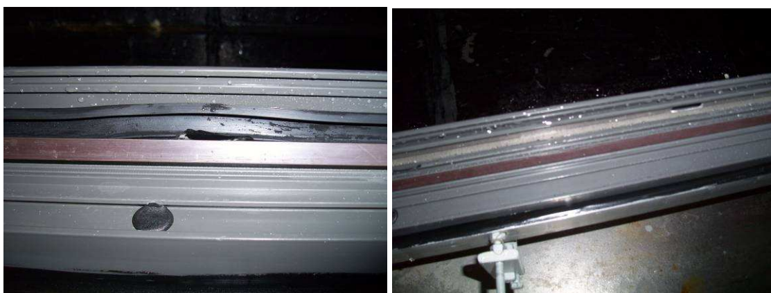
Foto N°.5. Detalle de corte de gomas y drenaje.
