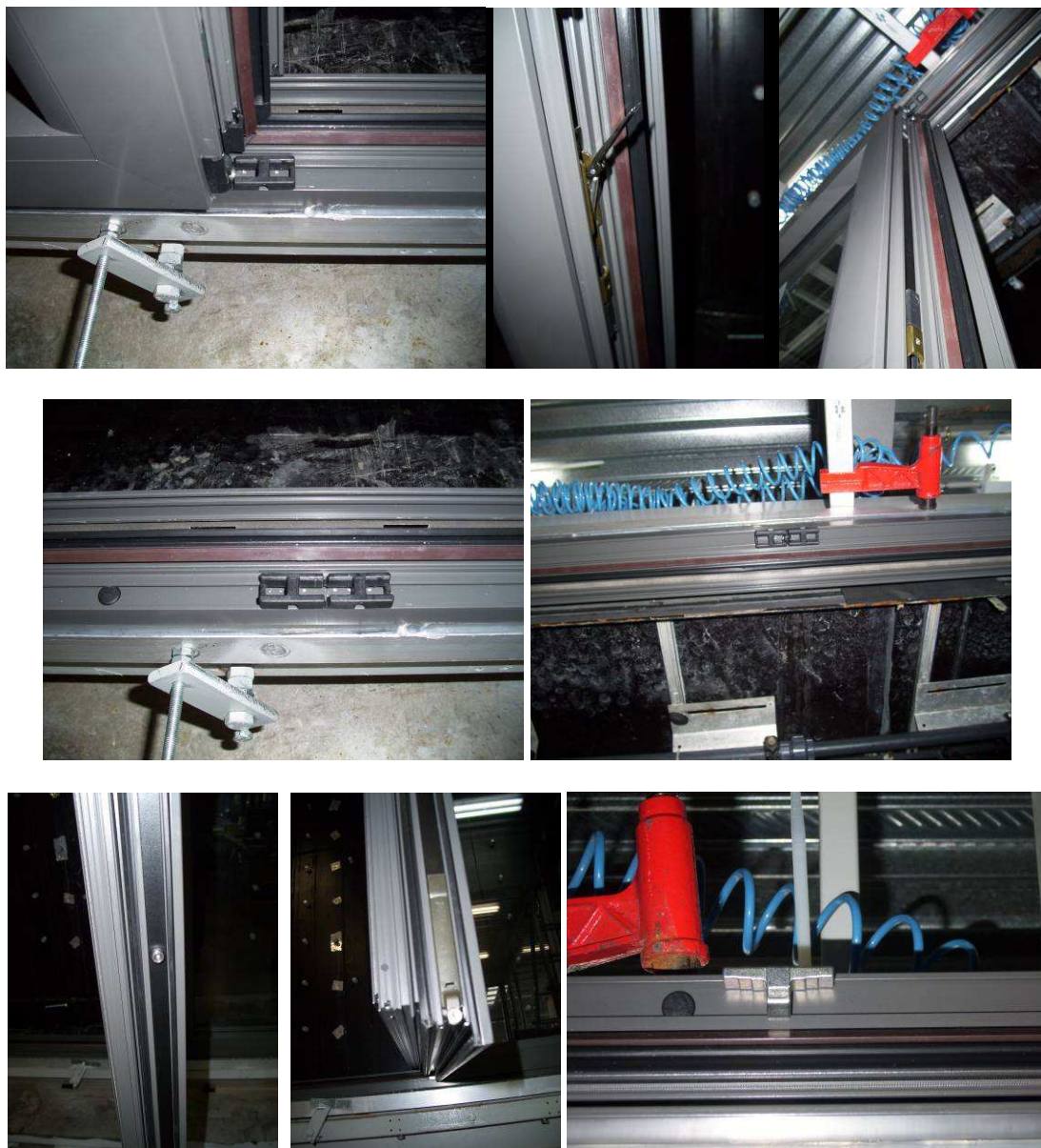
Foto N°.3. Detalle de cierres, perfiles y juntas.
