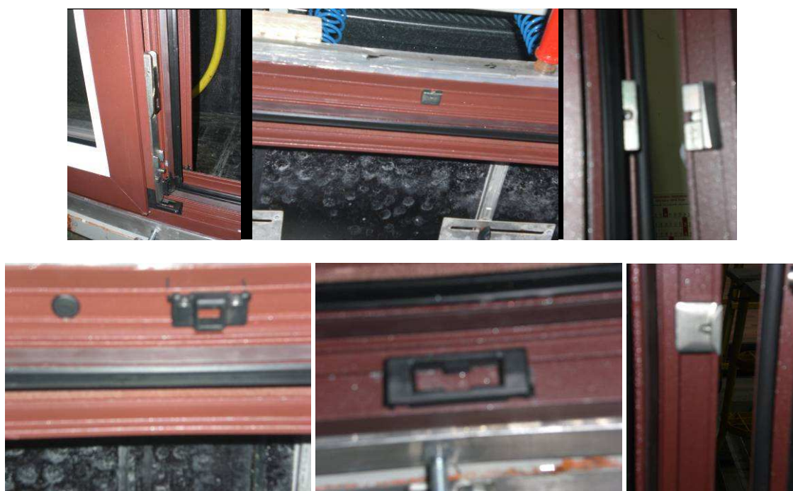
Foto N°.4. Detalle de cierres, perfiles y juntas.
