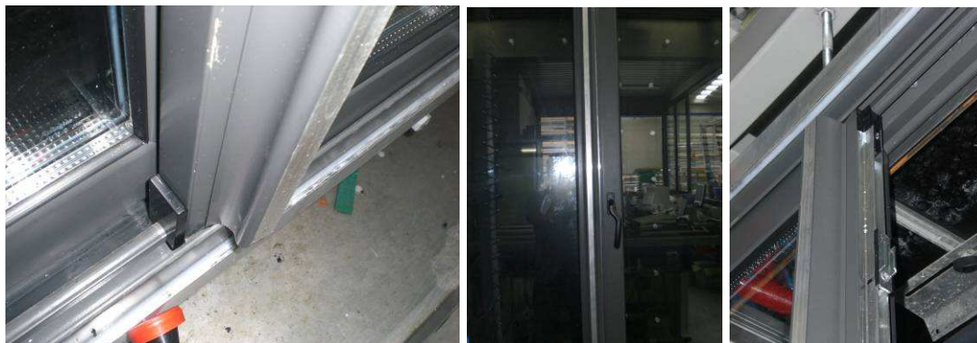
Foto N°.3. Detalle de cruce de hojas, perfil de refuerzo y perfil de cierre central.
