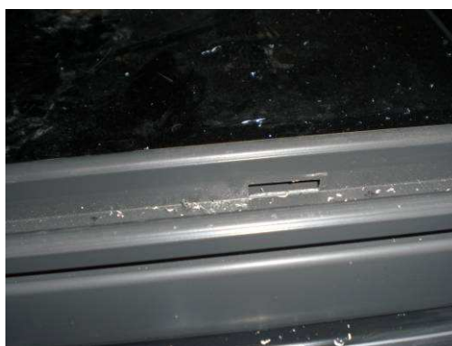
Foto N°.4. Detalle de drenaje.
