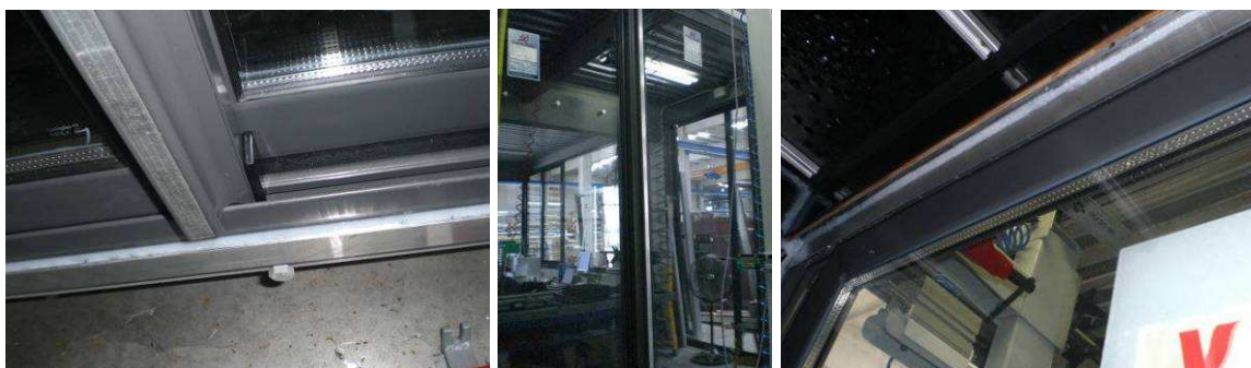
Detalle de perfil de marco, refuerzo y vierteaguas.
