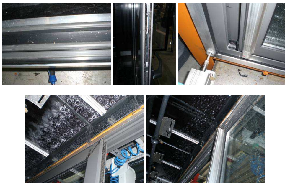
Detalle de perfiles de marco, hoja, refuerzos y vierteaguas.
