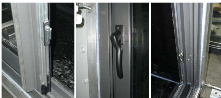
Foto N°.4. Detalle de manilla, punto de cierre de hoja con marco y entre hojas.
