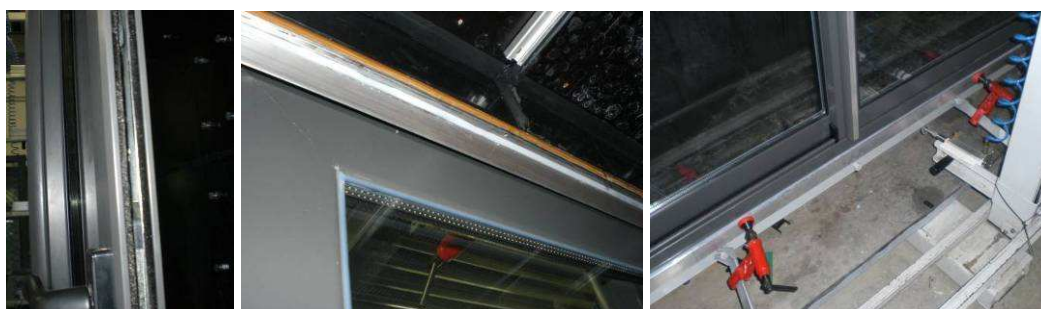
Foto N°.2. Detalle de perfil de marco, refuerzo, hoja y vierteaguas.
