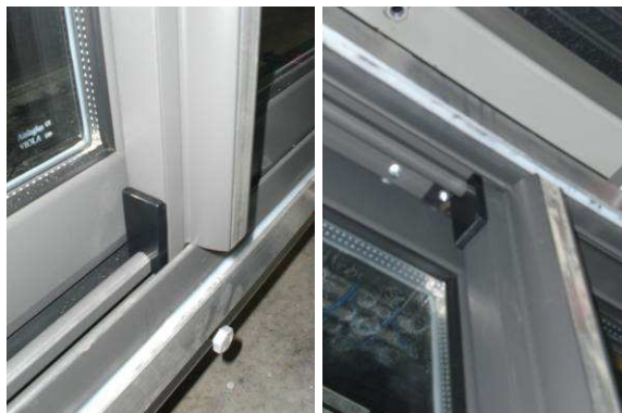
Foto N°.3. Detalle de cruce de hojas y perfil de refuerzo.
