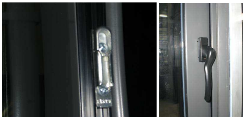
Foto N°.3. Detalle de manilla y cierre de hojas con el perfil del marco.
