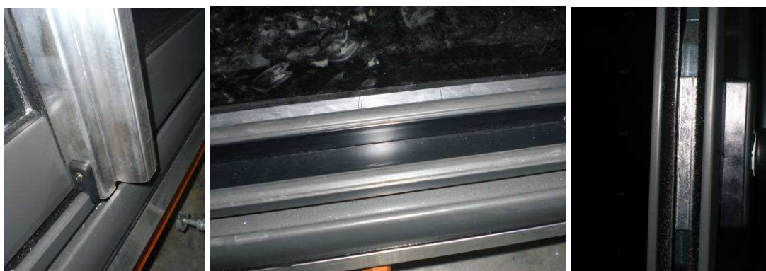
Foto N°.2. Detalle de perfiles de marco, hoja, refuerzo y cruces.
