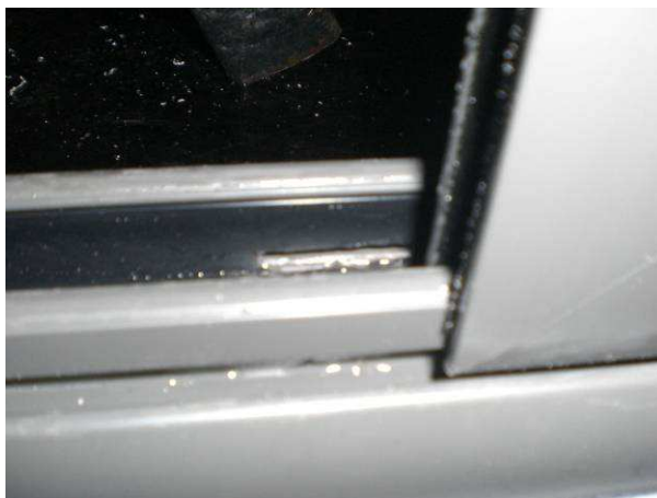
Foto N°.6. Detalle de drenaje y perfil perimetral.
