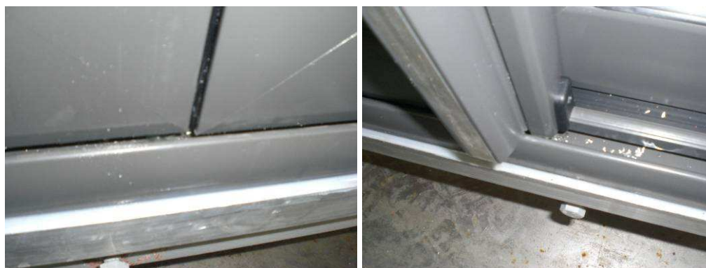
Foto N°.5. Detalle de cruce de hojas lateral con central y centrales.
