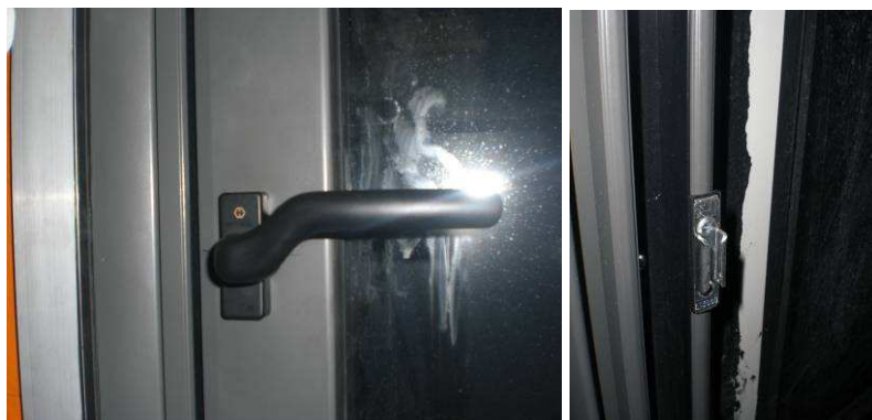
Foto N°.4. Detalle de manilla y punto de cierre.
