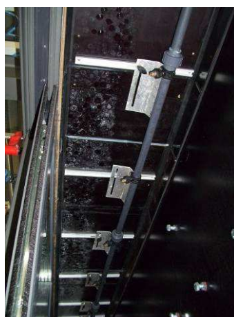
Foto N°.2. Detalle de rociadores y del perfil de vierteaguas.
