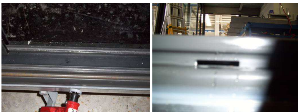
Foto N°.5. Detalle de perfil perimetral inferior y drenaje.
