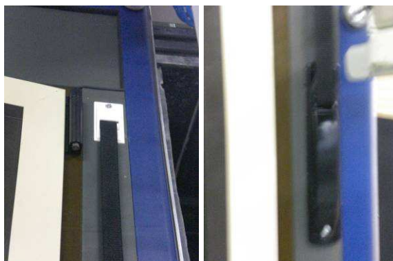
Foto N°.4. Detalle de salidas de cinta de persiana.
