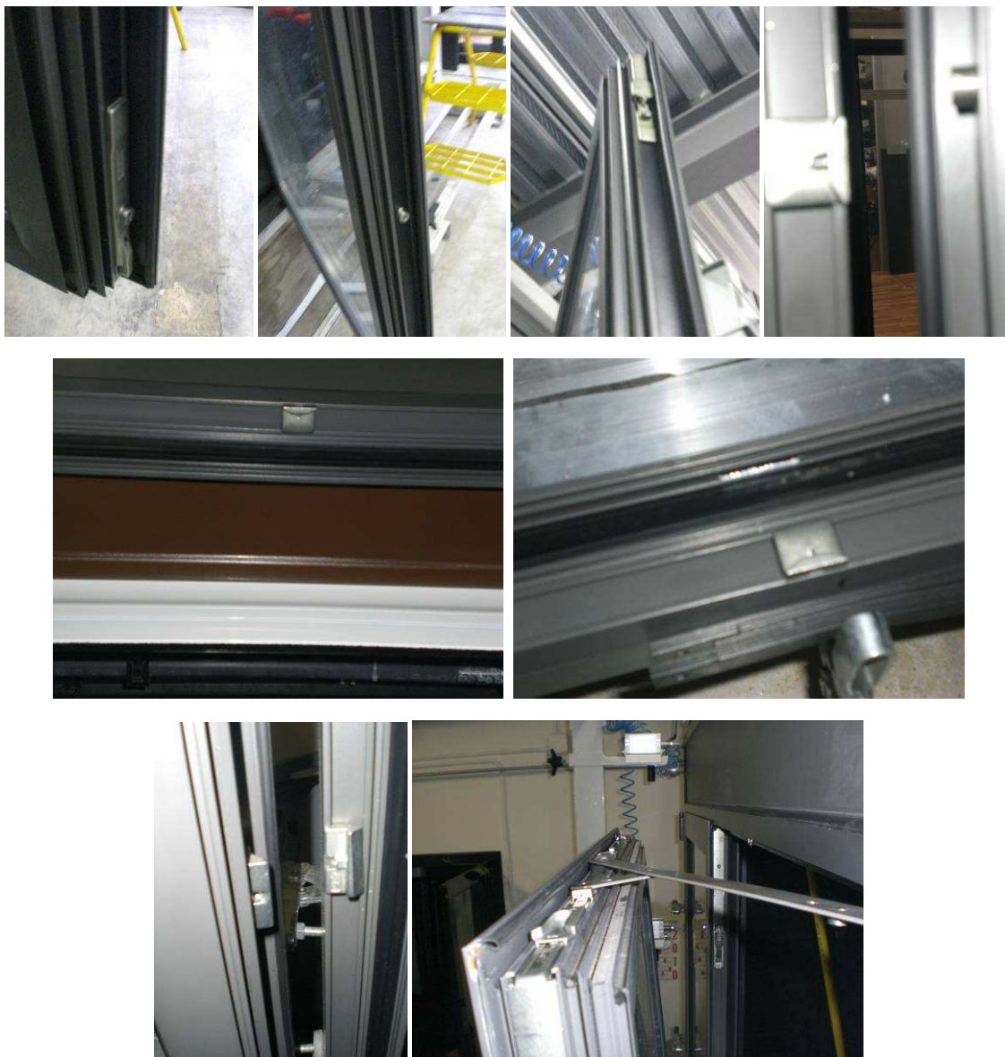
Foto N°6. Detalle de perfiles, juntas y puntos de cierre.
