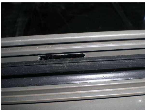
Foto N°6. Detalle de drenaje y junta de goma..
