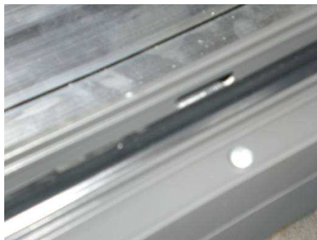
Foto N°.7. Detalle de perfil inferior, junta y drenaje.
