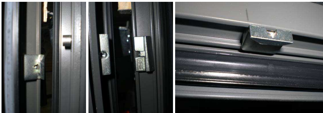
Foto N°6. Detalle de drenaje y junta de goma..
