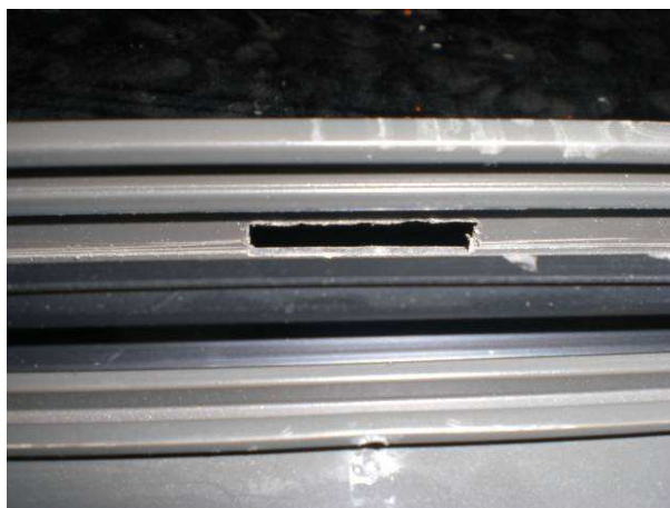
Foto N°.5. Detalle de drenaje.
