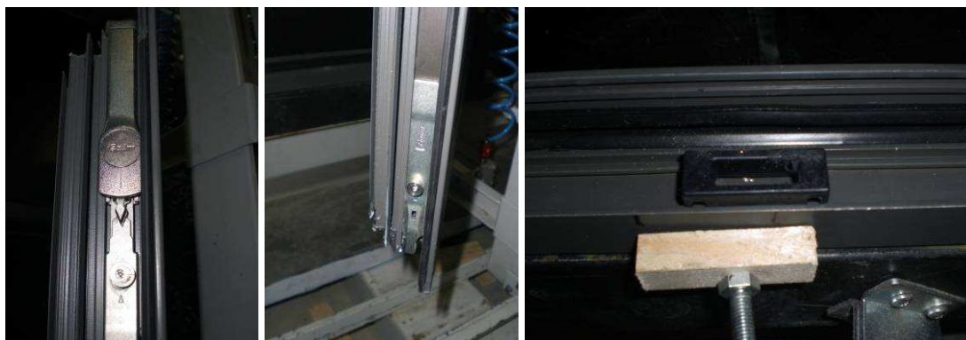
Foto N°.5. Detalle de puntos de cierre.
