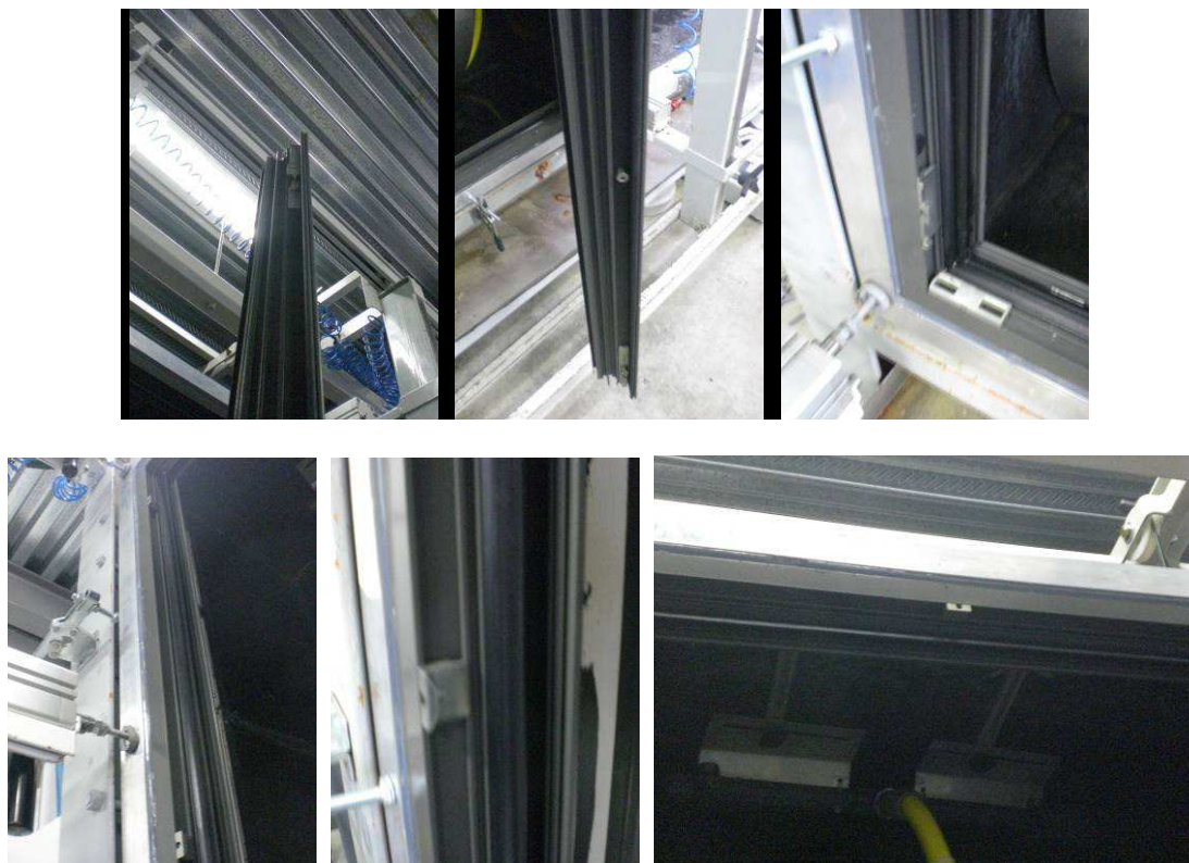
Foto N°.4. Detalle de cierres, perfiles y juntas.
