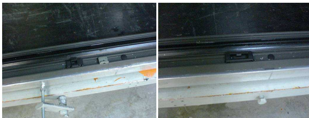
Foto N°.5. Detalle de la zona de goteo de agua.
