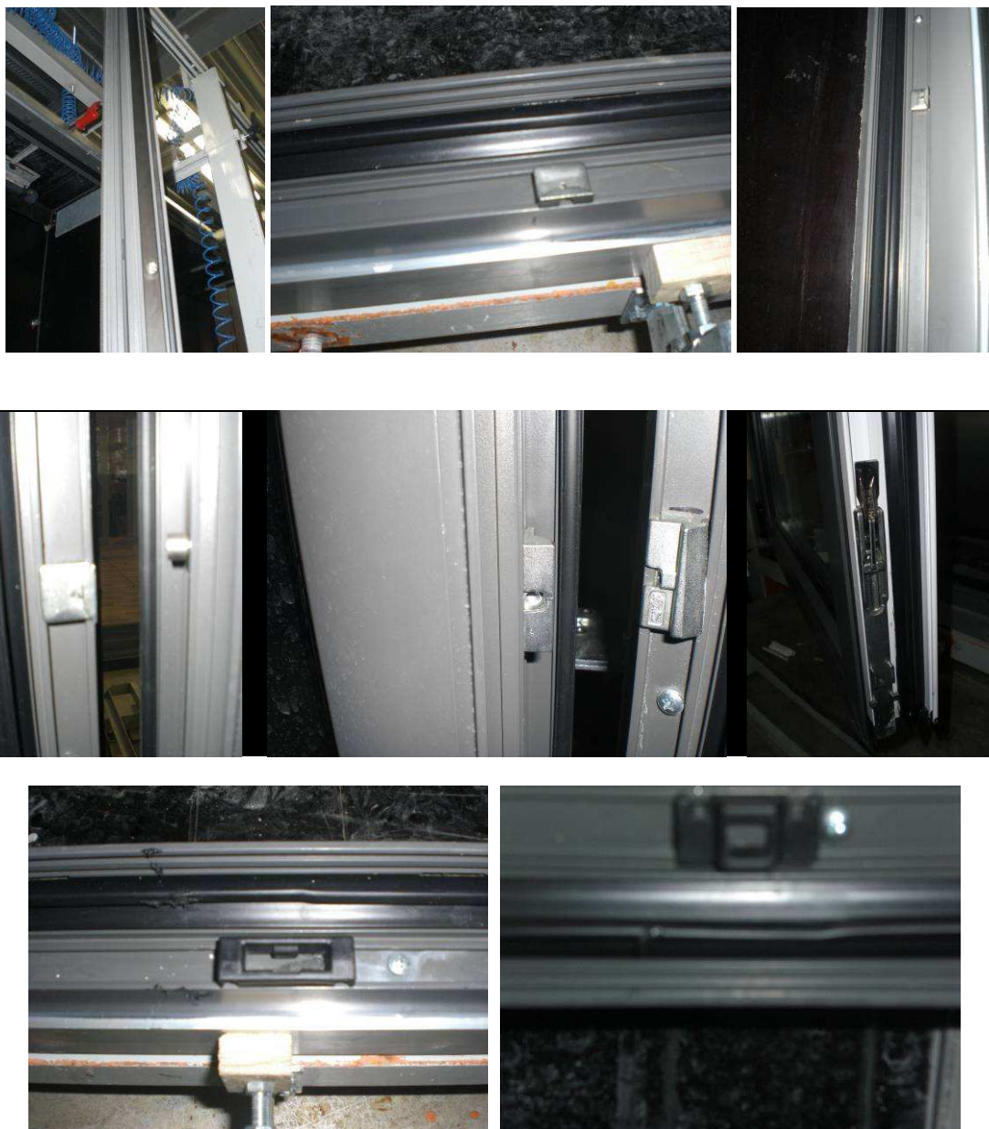
Foto N°3. Detalle de perfiles y puntos de cierre.
