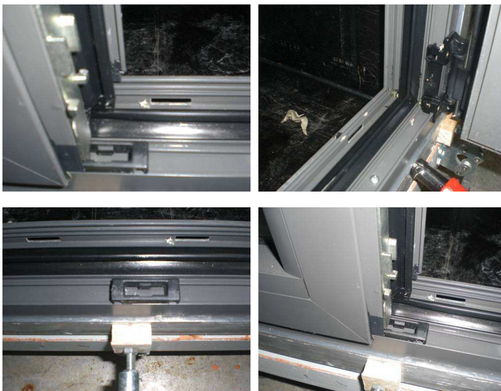
Foto N°5. Detalle de perfiles, drenajes y juntas.
