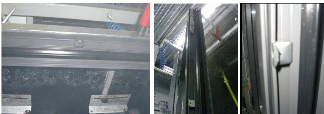
Foto N°5. Detalle de perfiles, drenajes y juntas.
