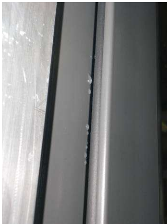
Foto N°.6. Detalle de la zona de goteo de agua.
